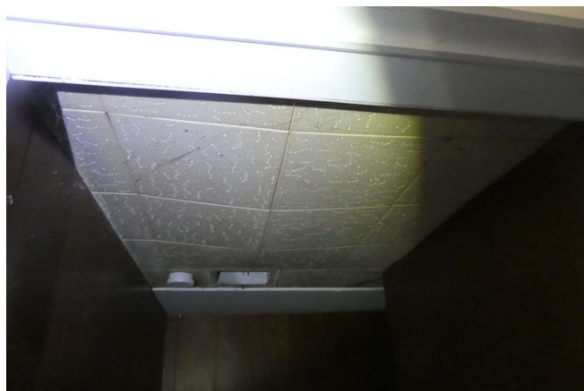
Cage d'escalier (RDC)
