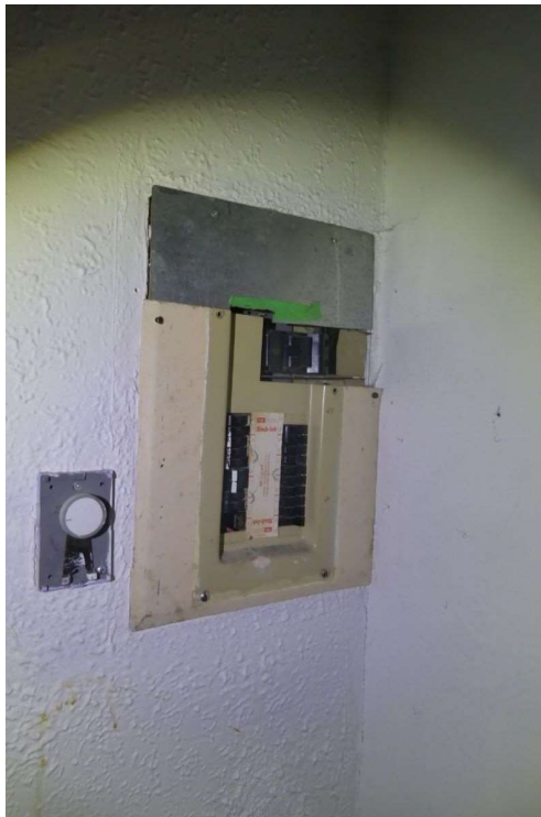
Panneau électrique Stab-lok
