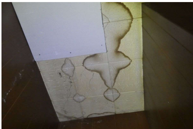
Cage d'escalier (RDC)
