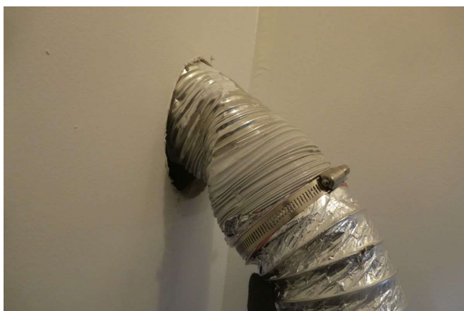
Salle de lavage (RDC)
