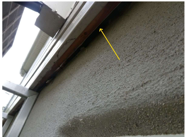
Revêtement extérieur (vu du bas)
