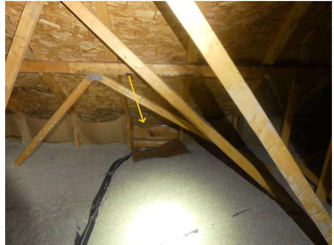
Grenier (façade gauche)
