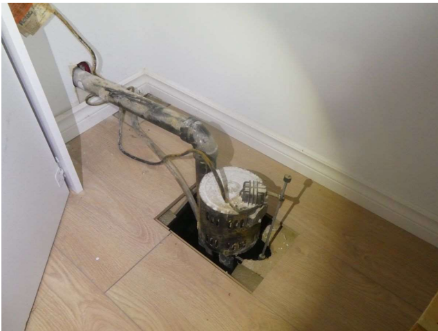
Sous-sol (CAC avant)
